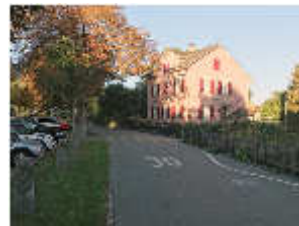
Im Zuge der Strassensanierung Grabenstrasse und Stadtgraben müssen auch die Werkleitungen, Strom, Wasser und Gas ersetzt werden.
