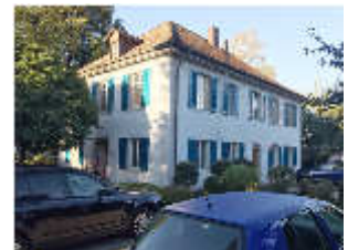
Das Obergeschoss des ehemaligen Casinos kann nach umfassender Sanierung wieder genutzt werden.
